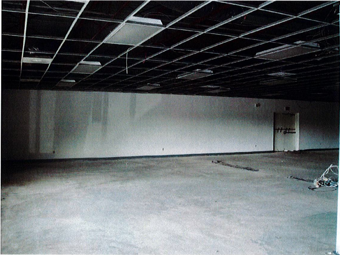
Photo 23 – Vacant tenant space.
