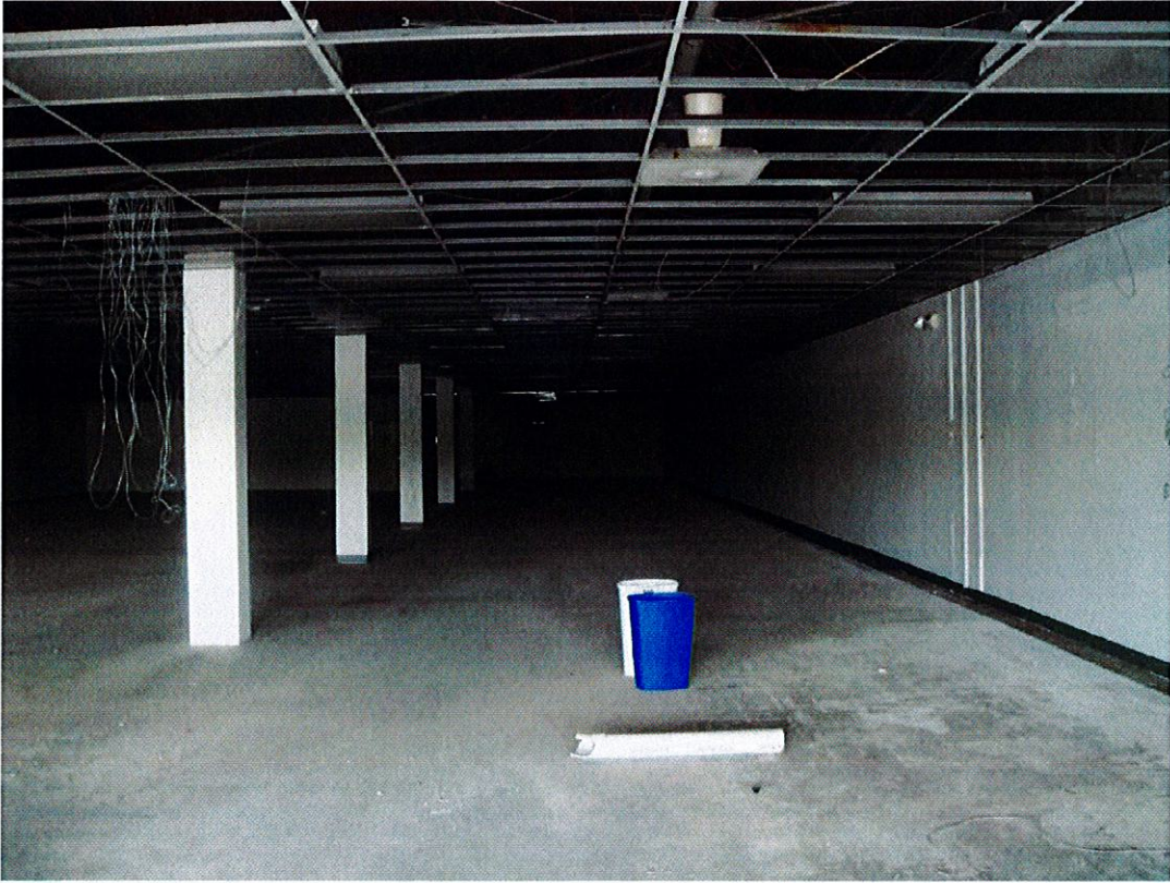
Photo 24 – Vacant tenant space.
